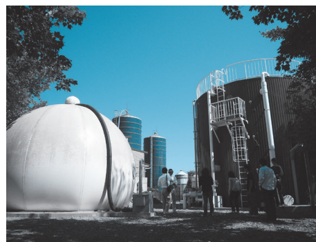
写真 2-1 牧場に併設された畜ふんバイオマスシステム
