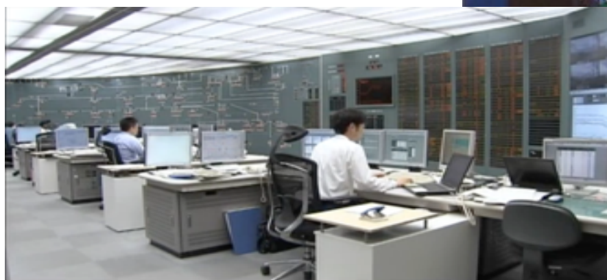
東京電力中央給電指令室 (同社HPより)
