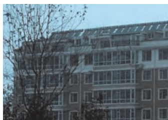
屋根に取り付けられた太陽熱温水器
