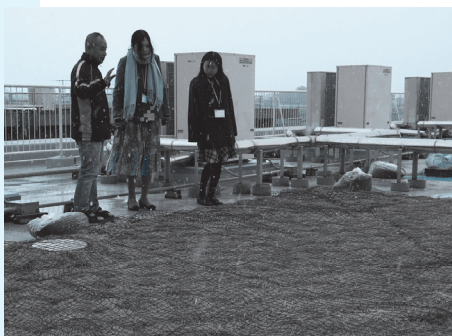
ノシバを使った屋上緑化の様子
