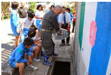
小学校の前にピコピカ発電機の設置
