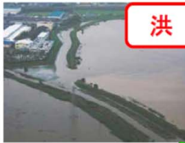
図：洪水被害の事例 (国土交通省中部地方整備局提供)
