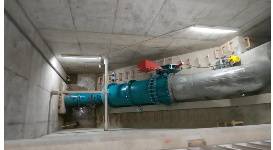
住宅にすると約100軒分の電力量
