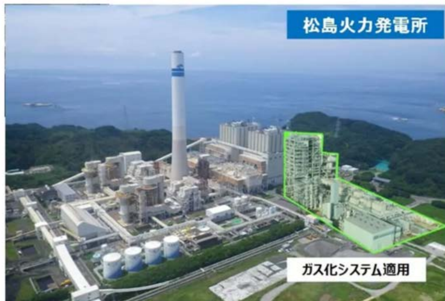
松島火力発電所のガス化設備（緑枠）の完成イメージ図（電源開発提供）
