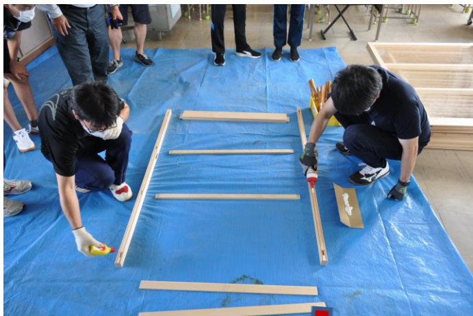
窓枠の組立て
