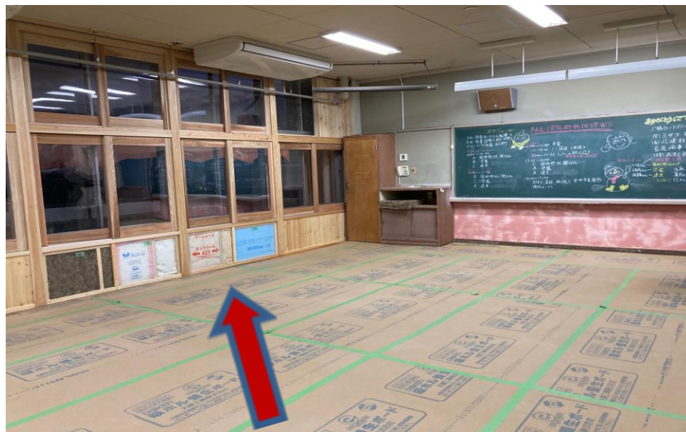
4種類の断熱材が見えるようにアクリル板でカバー
