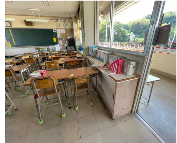
改修前の教室
