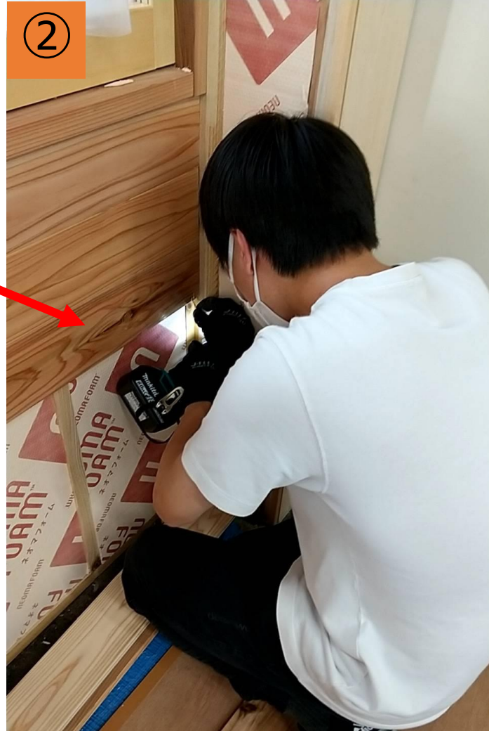
② 木板設置
