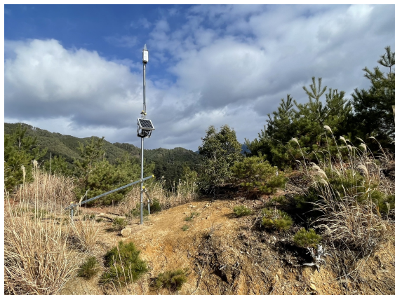
LPWA通信設備 標高1,100メートルの 山頂に整備
