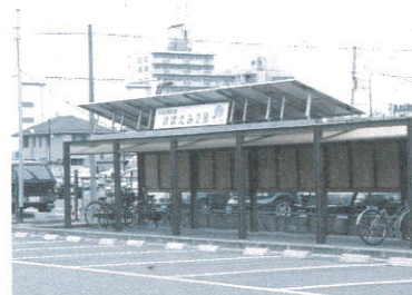
設置された太陽光パネル
