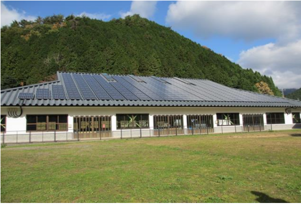
西粟倉村コンベンションホール
