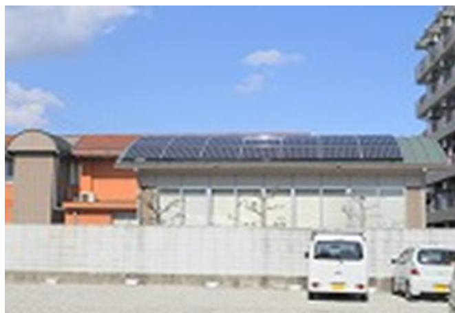
瀬戸町図書館—4kW（2012年）
