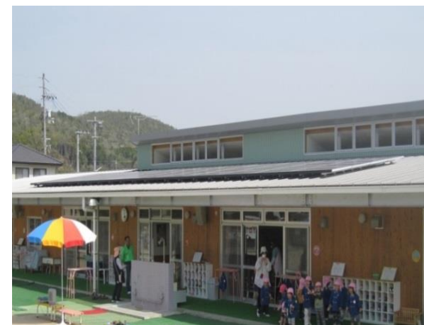
建部保育園—10.56kW（2013年）
