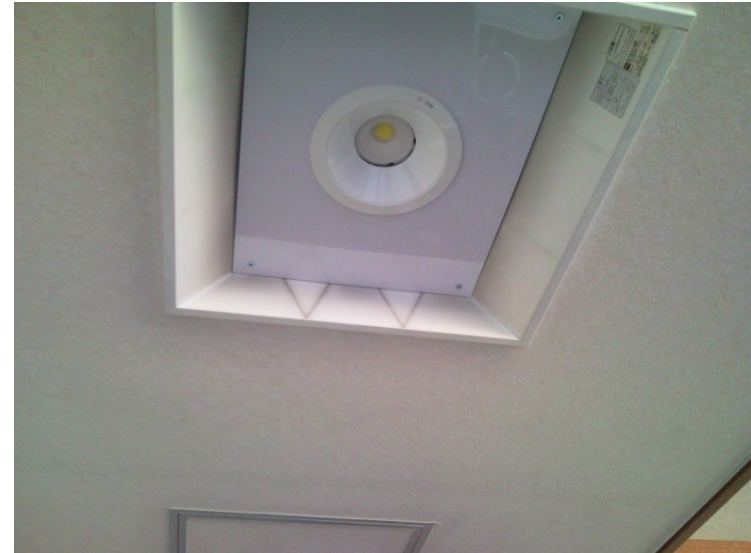
LEDダウンライト 消費電力 19.9W 効率 76.4lm/W
