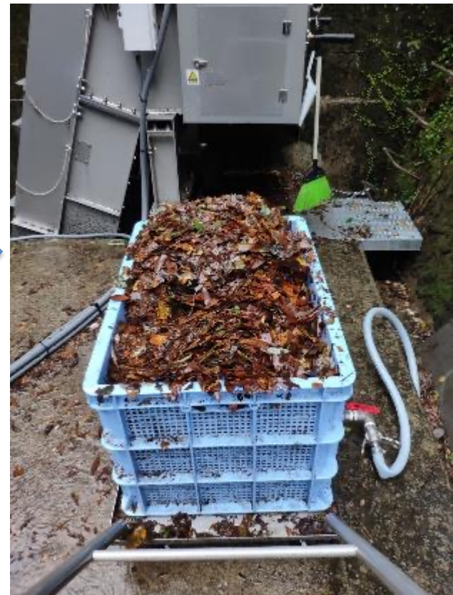
新発電所除塵機
